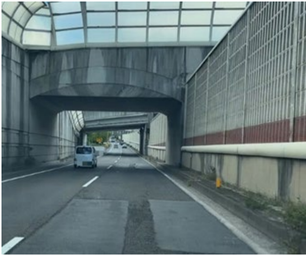
図-10 部分補修の箇所
