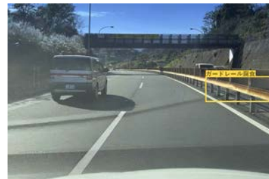
図-6 ガードレールの不具合検知例
