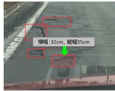
図-5 ポットホールの検知例
