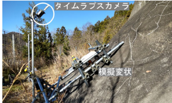
写真3 撮影状況（上：トンネル覆工，下：模擬変状）
