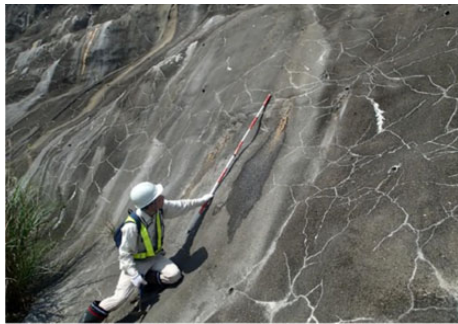
写真-2 目視点検の例
