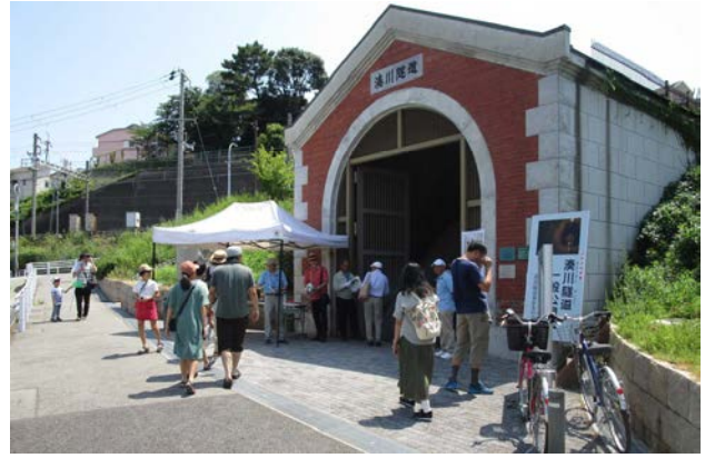
写真2.1 湊川隧道門扉（定期一般公開時）
