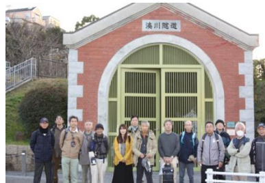
図-3 湊川隧道斜坑坑口前
