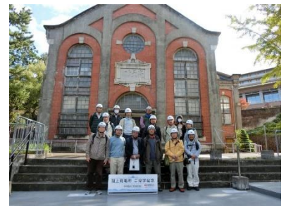
図-1 関電第3発電所前
