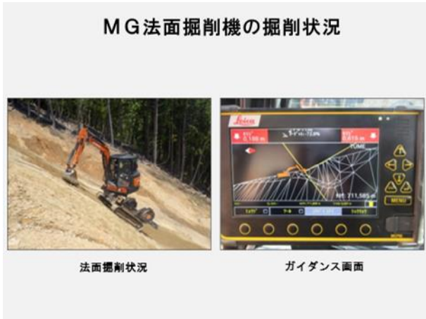
図-6 MG法面掘削機の施工状況
