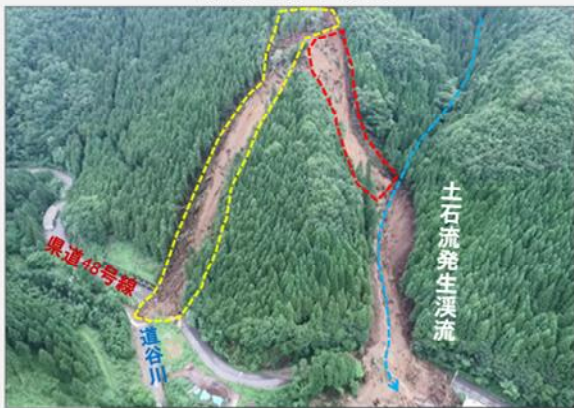
図-1 崩壊発生直後(平成30年7月)
