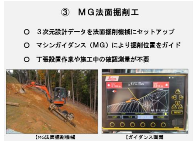
図-5 MG法面掘削工の施工状況
