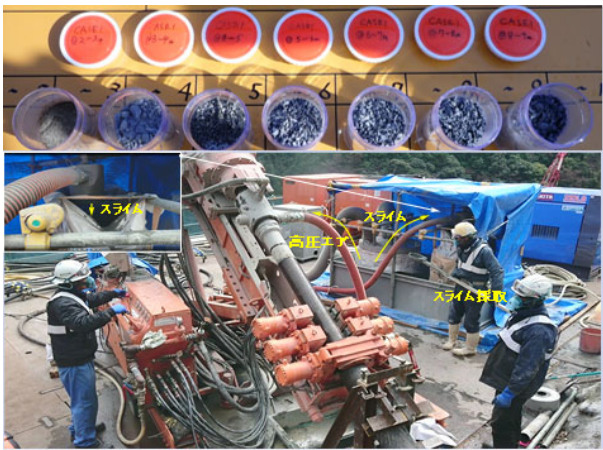
写真-3 削孔スライム採取状況
