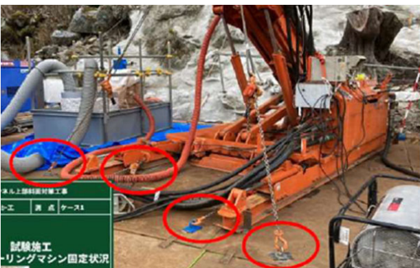
写真-2 削孔機固定状況
