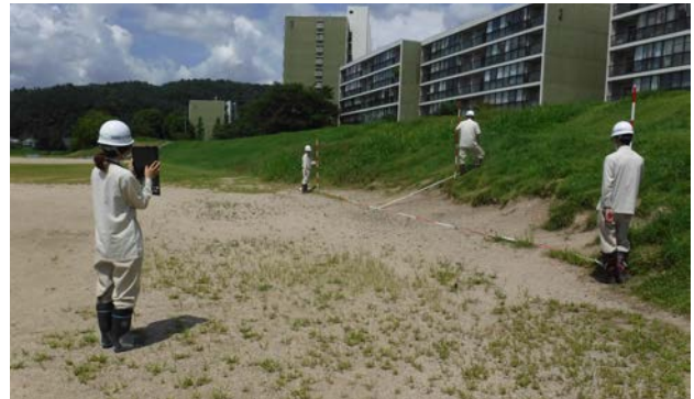
写真-2 堤防の変状記録状況
