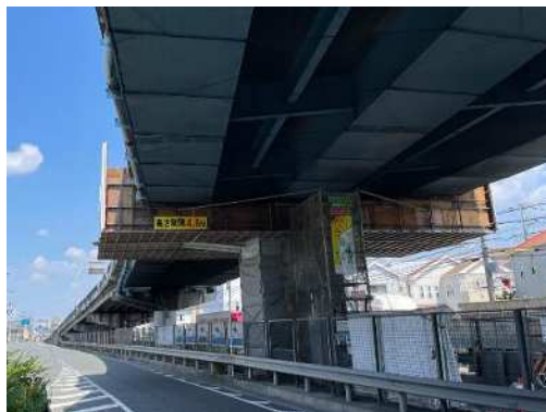
写真5 施工足場設置状況
