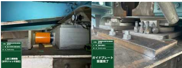
写真-2 横移動構造 (左：水平ジャッキ, 右：ガイドプレート)
