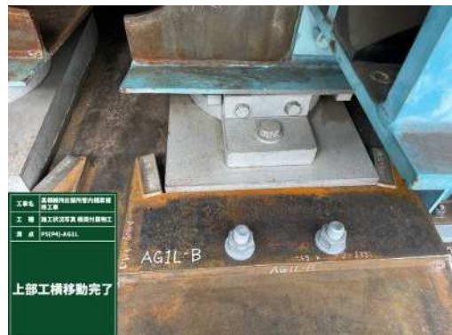
写真7 移動完了時橋座状況
