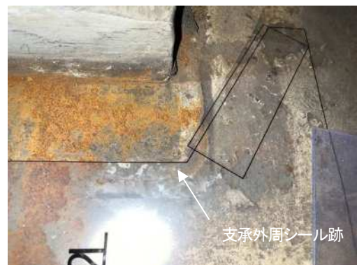
写真-3 ガイドプレート製作実測状況
