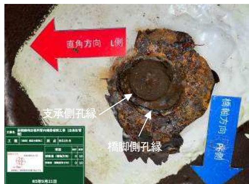
写真8 セットボルト孔整合状況
