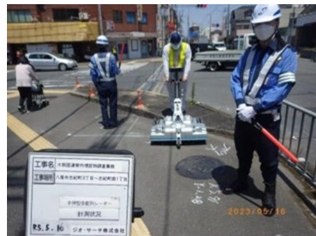
図-6 現地調査状況
