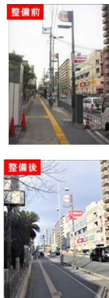
図-1 無電柱化の整備前と整備後
