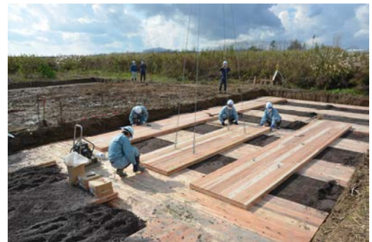
図-1 CLT による地盤補強の現場実験
