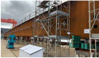
図-4 仮組立の状況
