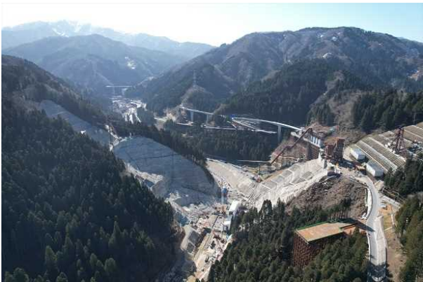
写真-1 堤体打設状況写真（2023年3月）
