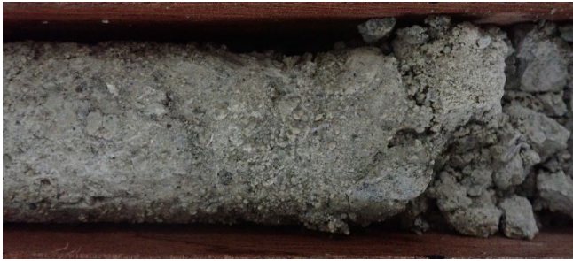
写真-2 T-14 孔のボーリングコア接写 (GL-16.2~16.3m)
