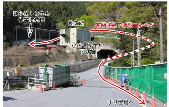
図-1 密閉式吊下げ型コンベヤ設置状況
