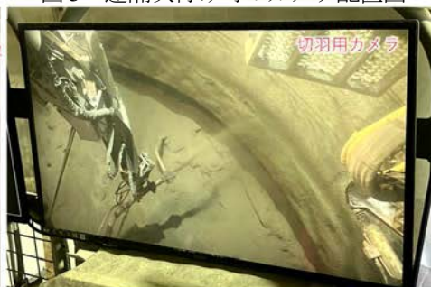
図 4 遠隔操作モニターによる遠隔吹付け状況
