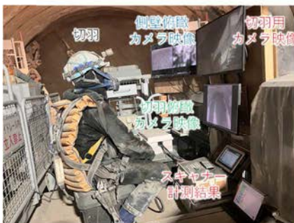
図 4 遠隔操作モニターによる遠隔吹付け状況
