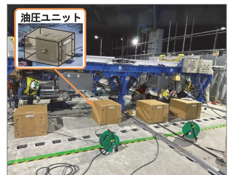
図 6 油圧ユニットでの夜間使用状況 (4 台同時稼働)
