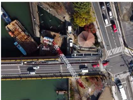
図-7 クレーン台船設置状況
