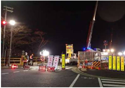
図-10 唐橋夜間通行止め状況写真
