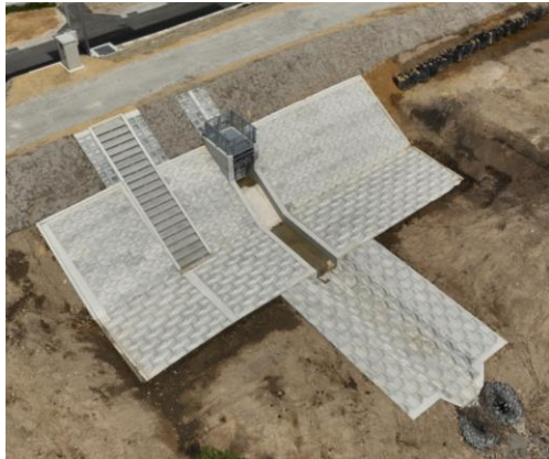
図-3 施工完了後の樋門
