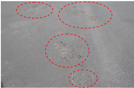
図-11 舗装面の荒れ
