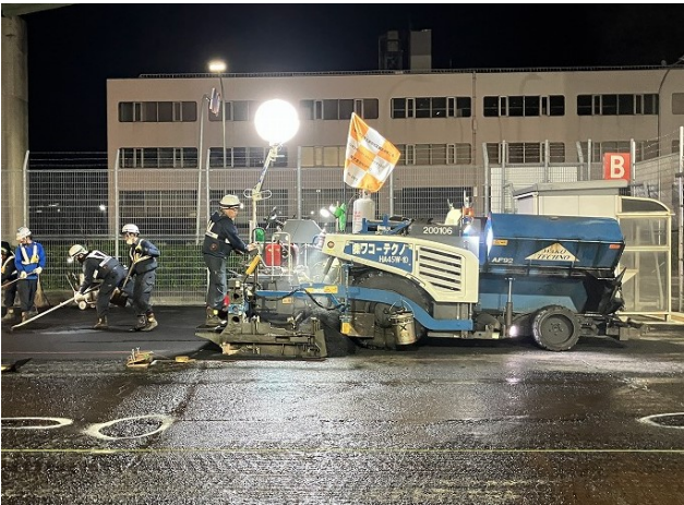
図-10 本施工の状況
