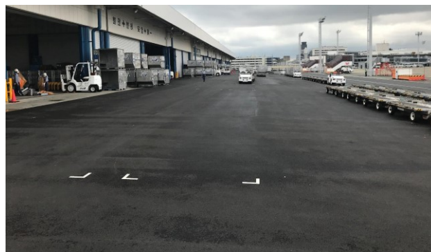
図-14 工事完了後の状況（エアサイド側）
