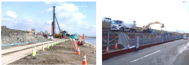
図-13 船着場及び裏のり面盛土工事
