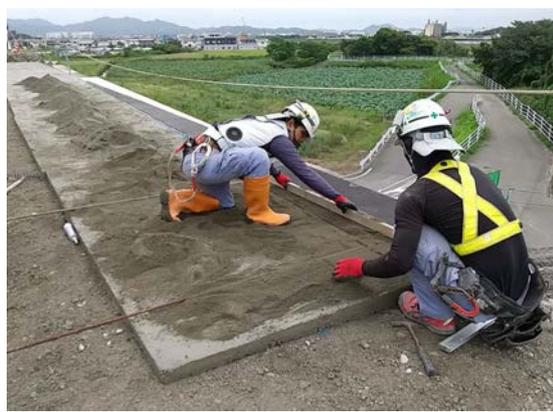
写真.2 据付前の基面整正
