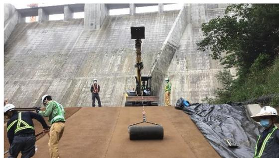
図-2 施工状況(転圧状況)
