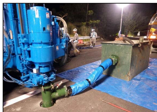
図-6 排泥回収状況
