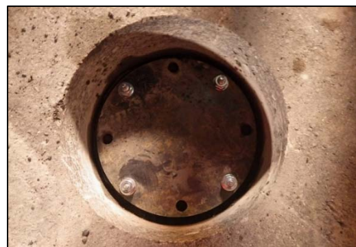
図-8 路面仮復旧用鉄板設置
