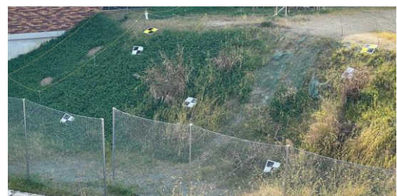
写真 1 計測対象斜面
