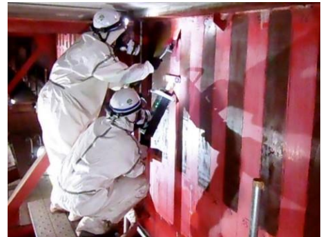
写真-1 IH 塗膜剥離施工の例
