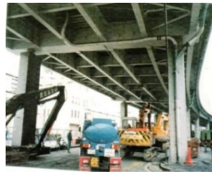
図 5 橋脚と橋桁の構造
