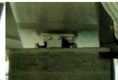
横桁方向に見る. (柱幅 > 横桁幅) 図 6 支承側面
