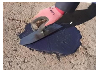
写真-2.1 HCP 施工状況
