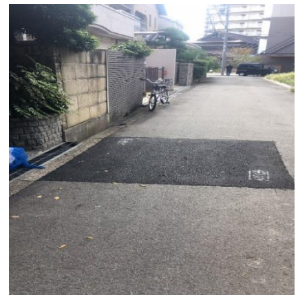
図1 舗装工事跡の残る街並み
