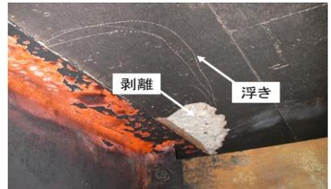
写真-1 合成桁橋の損傷状況<sup>1)</sup>
