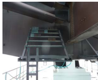
図2 暴露試験の状況
