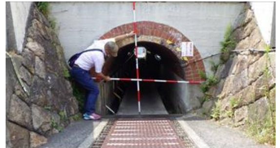
図-1 鉄道盛土横断レンガ積みトンネル
