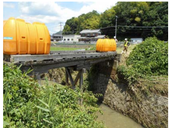
写真-1 新町橋の全景 (荷重載荷時)
