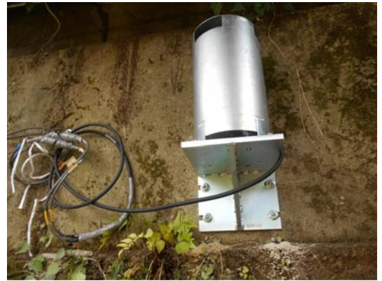
写真-3 設置状況
