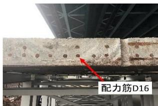
図2 RC床版の切断面 (橋軸直角方向)
