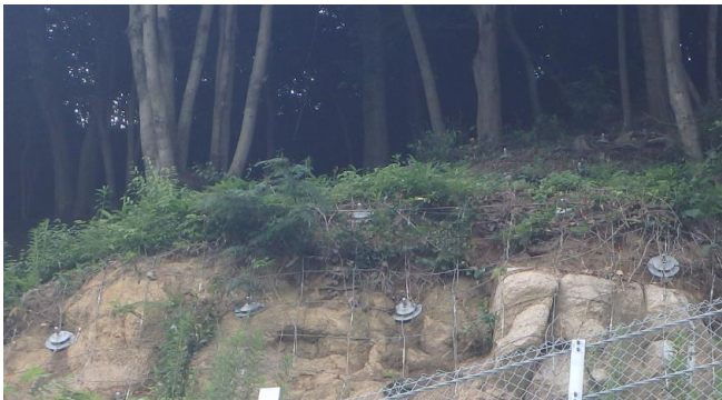
写真 3 RR 工法施工箇所
