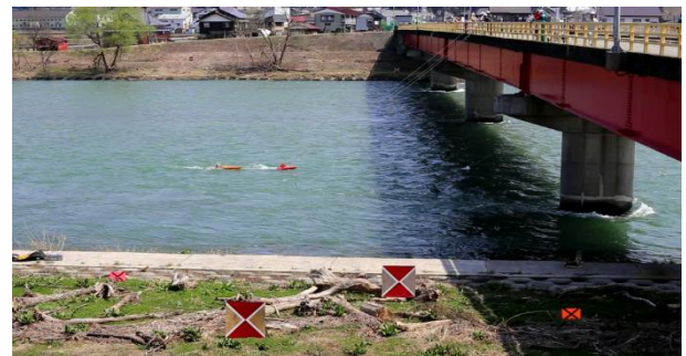
図-1 根小屋橋観測地点
