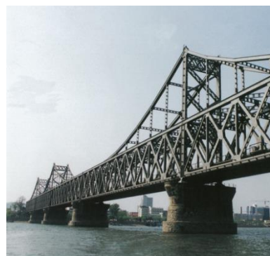
図-3 鴨緑江大橋
