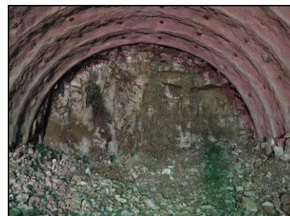
図2 画像処理前のトンネル切羽画像
