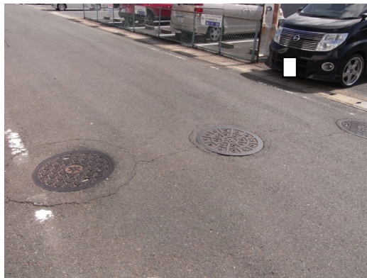
図-4 狭小範囲に近接するマンホール(向島地域)
