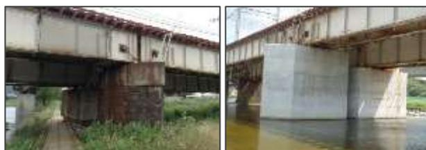
図1 対象橋脚外観 (左図:補強前, 右図:補強後)
