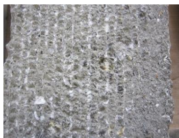
図-1 切削コンクリート面例
