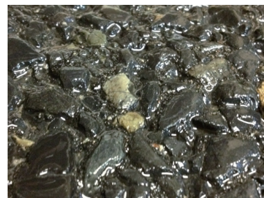
写真-1 路面の状況
