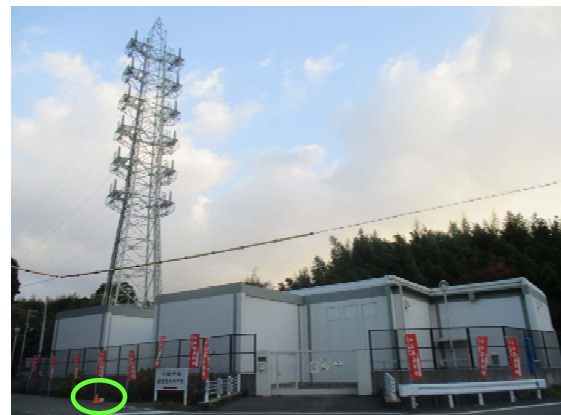
写真-1 変電所(敷地外の極近傍)での常時微動計測状況例
