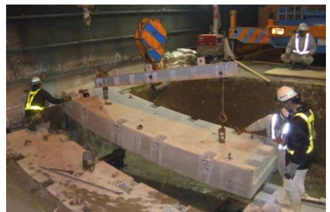
写真-3 プレキャスト版設置状況
