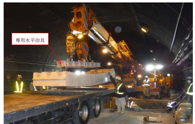
写真-2 運搬車、クレーン配置状況
