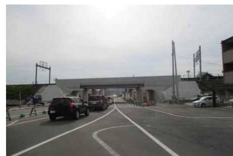
写真 3 六十谷陸橋 完成（下り線側より）
