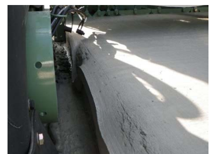
写真-3 エッジスランプ発生状況
