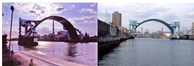
写真-5 木津川水門（左）と尻無川水門（右）
