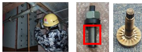
(a) 片面からの当て板施工状況 (b) ワンサイドボルト (c) スタッドボルト
