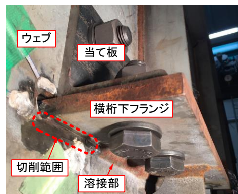
写真-1 ビード切削状況(試験部 B)
