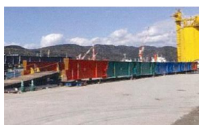
(a) 緊急仮設橋全景
