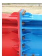
(b) 緊急仮設橋連結部
