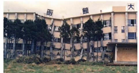
1階は全面破壊・中央部の柱は全階で破壊
